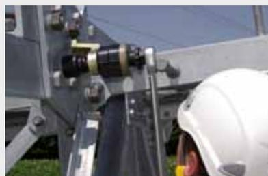
**alkitronic® M** pour les travaux de montage sur des poteaux électriques, serrage précis avec une clé de couple.
